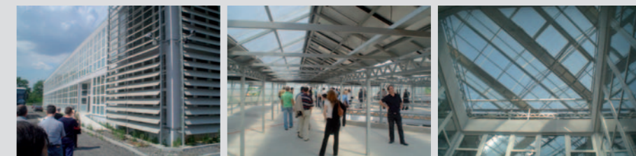
Tvornica konfekcije Kuća mode STILIN. Plus-energetska arhitektura kao fotonaponska elektrana-energana. Prva faza ostvarenja osigurava 36.1 kW električne struje iz sunčeve energije. Projekt 2000., ostvarenje 2005. Zagreb. Autor: Ljubomir Miščević
